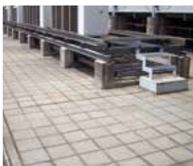
既存タイル下地
