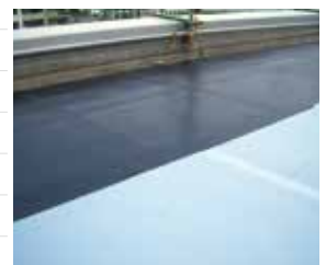
オルタックシート貼り
