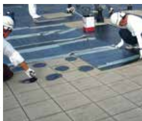
バリボードPS(アスファルトパネル)貼り
